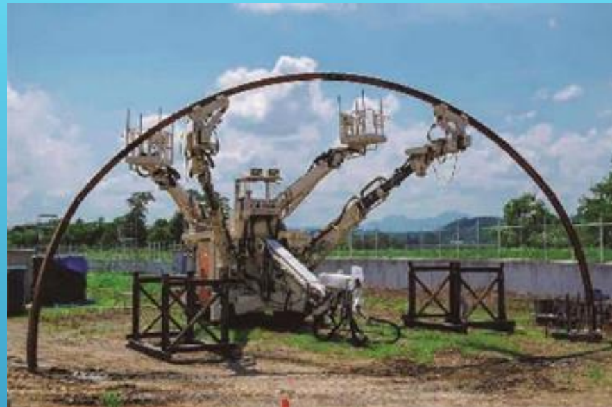
鋼製支保工建込みロボット
