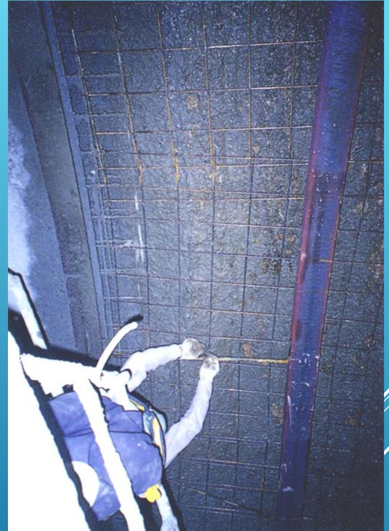
金網設置作業 (切羽直近高所での上向き作業)
